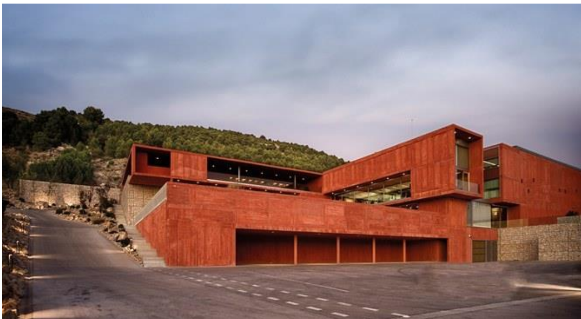
Ilustración 2: Instalaciones de Pago de Carraovejas
